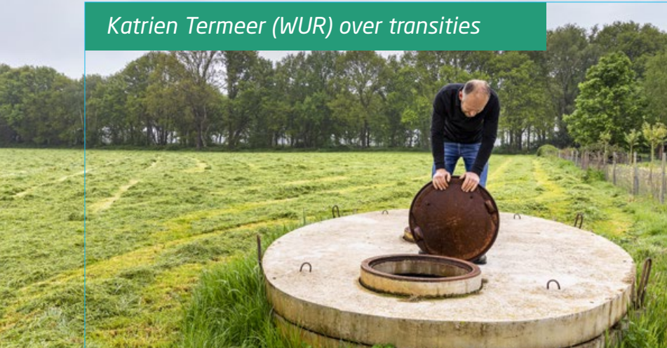
Via een verzamelput wordt het water verdeeld over sub-irrigatiesystemen.
