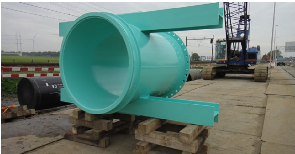
Overgangsstuk met de aangelaste stalen balken om de krachten over te brengen op de damwand.
