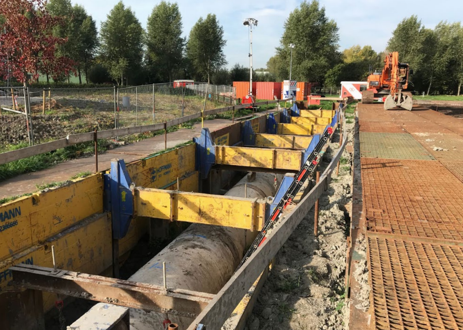
Reparatiewerk aan de tweede Bergambachtleiding, een van de twee grote transportleidingen die voorgezuiverd rivierwater uit de Afgedamde Maas naar de duinen brengen.
