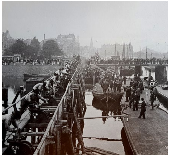
Afzinken van een drinkwaterleidingbuis in Amsterdam.
